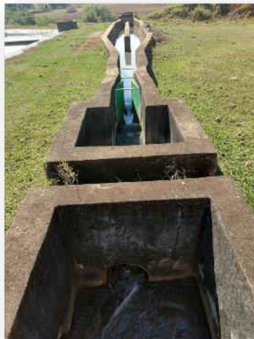
Figura 218 - Tratamento Preliminar desde Caixa Saída
