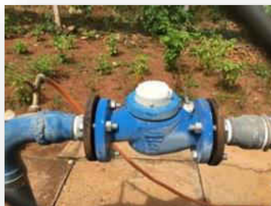
Figura 84 - Macromedidor do Poço COHAB II.
