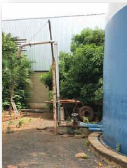
Figura 163 - Instalação para carregar caminhão pipa.
