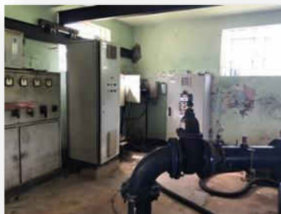
Figura 66 - Painéis elétricos da casa de bombas.
