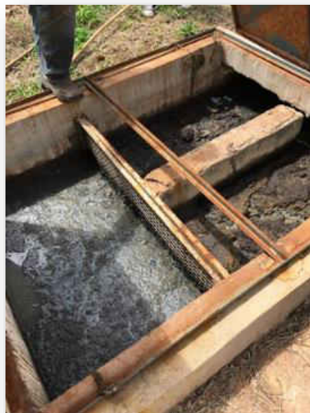
Figura 192 - Entrada de esgoto na EEE Verona.
