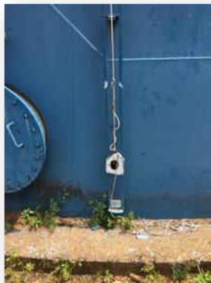
Figura 161 - Medidor de nível.
