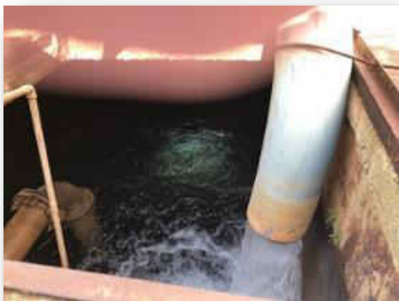
Figura 61 - Poço de sucção com bombeio do poço e dosagem de produtos químicos.
