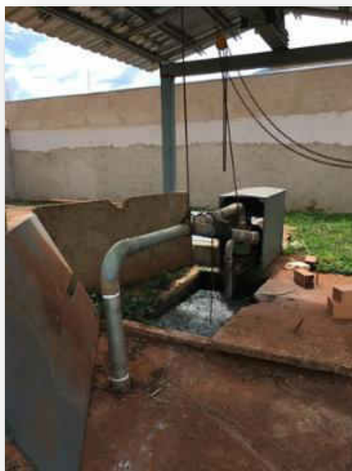
Figura 193 - Poço de sucção EEE Verona.
