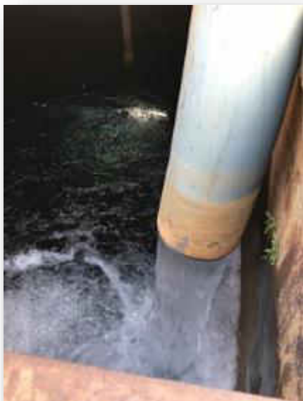
Figura 60 - Poço de sucção com bombeio do poço.
