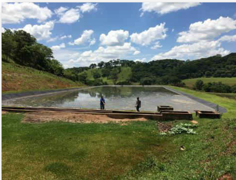
Figura 210 - Lagoa anaeróbia com tratamento preliminar na frente.
