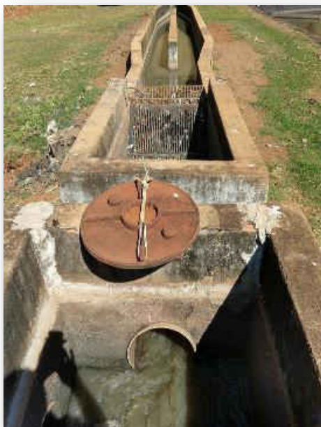
Figura 211 - Canal de chegada com pretratamento.
