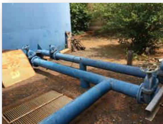
Figura 160 - Tubulações que interligam os reservatórios.
