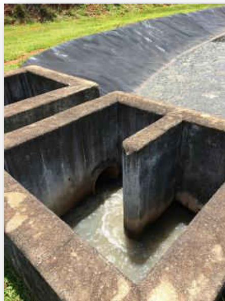
Figura 217 - Saída do tratamento preliminar.
