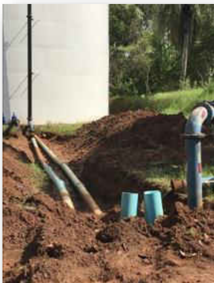
Figura 114 - Detalhe das tubulações conectando o poço Contendas ao reservatório.
