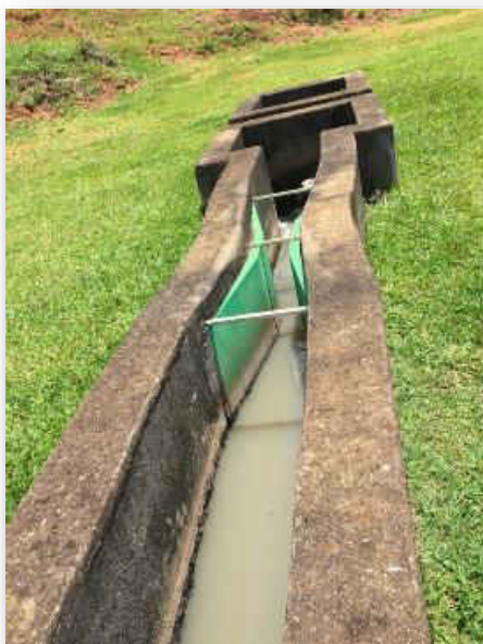
Figura 215 - Calha Parshall.
