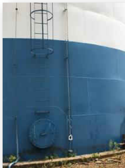
Figura 162 - Medidor de nível.
