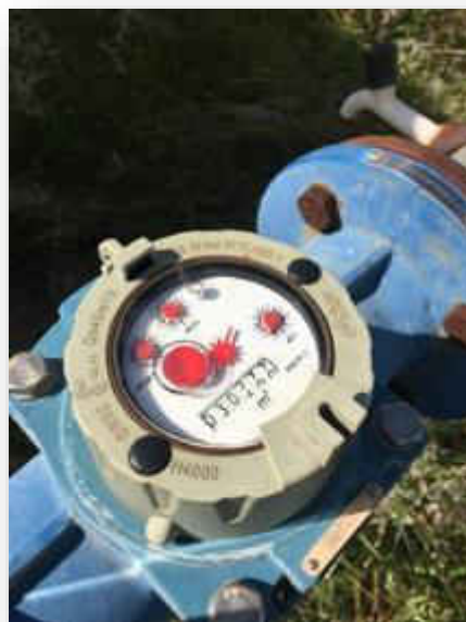
Figura 104 - Medidor do poço.
