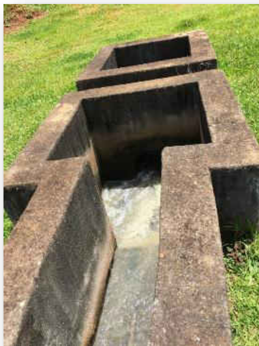
Figura 216 - Saída do Tratamento Preliminar.
