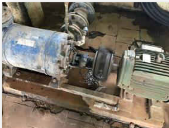
Figura 63 - Bomba para reservatório Girardi.
