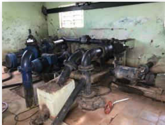
Figura 62 - Bombas de recalque.
